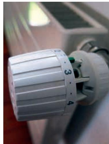
*Thermostatventile ermöglichen die Temperatur den Bedürfnissen entsprechen in verschiedenen Räumen unterschiedlich zu regeln.*
