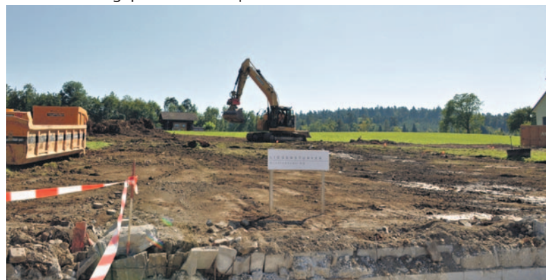
Auf diesem Grundstück an der Rütistrasse in Oberohringen entstehen 20 moderne, preisgünstige Mietwohnungen.
