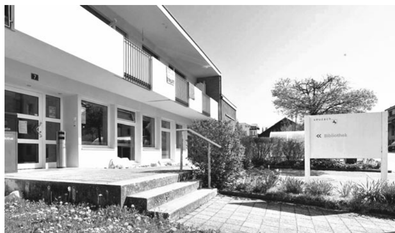
Der Verkauf des Jugendhauses und dessen Verlegung in die ehemalige Bibliothek an der Strehlgasse sorgten für einigen Diskussionsstoff.
