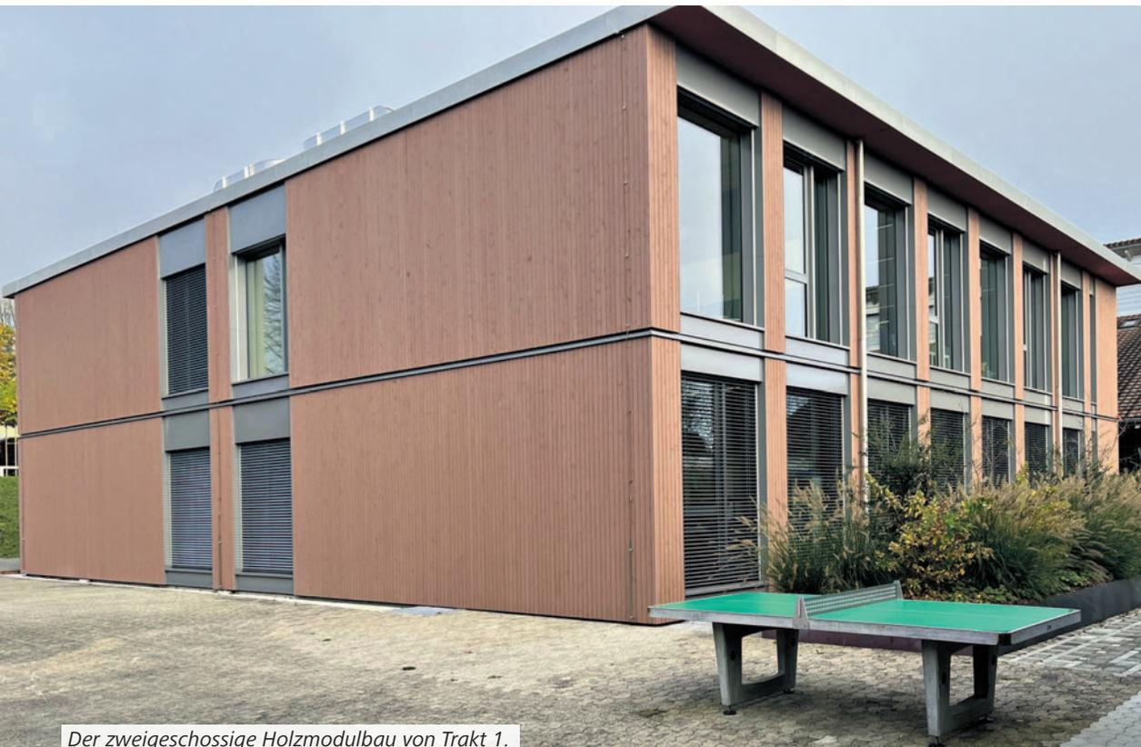
Der zweigeschossige Holzmodulbau von Trakt 1.
