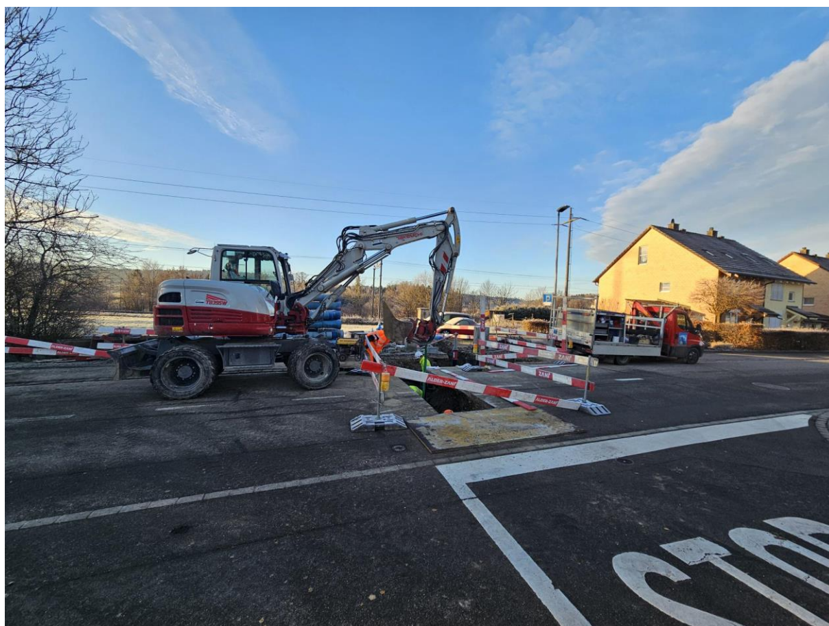
Bild: Sanierung Wasserleitung Grundstrasse, Herbst 2025, Abteilung Tiefbau
